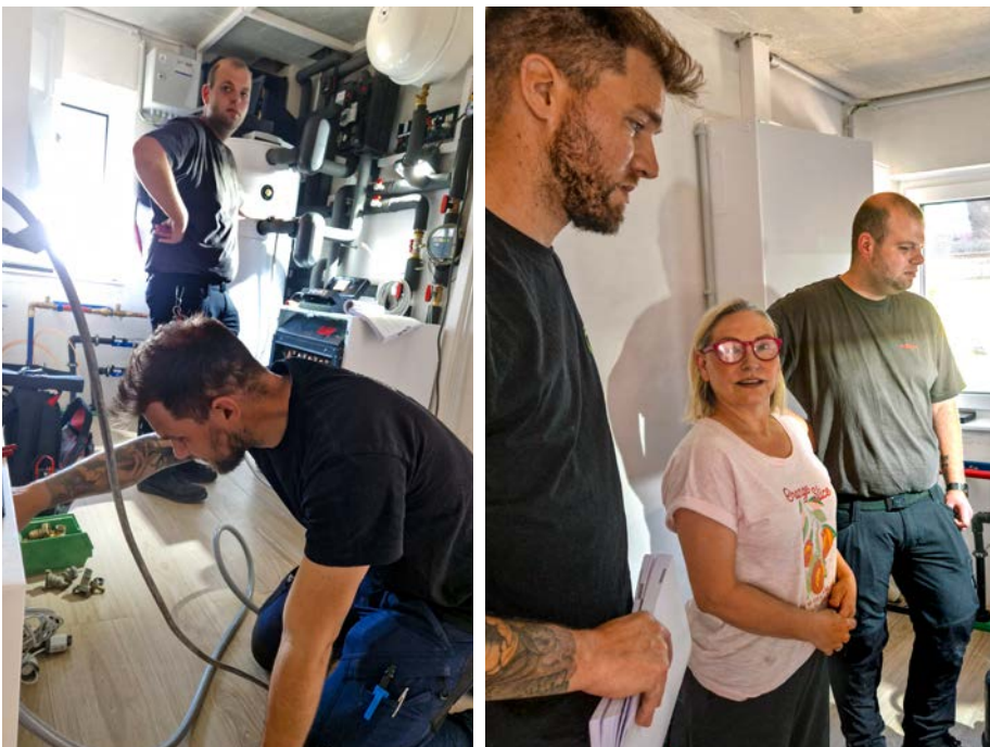
Installateur Jan Hölemann (vorne) und Max Hiller von Viessmann nehmen die Anlage in Betrieb und besprechen mit Bauherrin Tanja Weibel die Bedienung.
