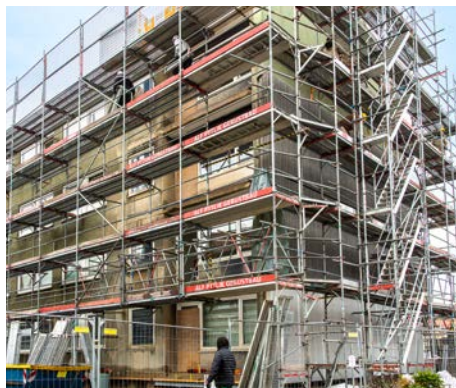
Die TAG Wohnen modernisiert Mehrfamilienhäuser zu KfW-Effizienzhäusern.
